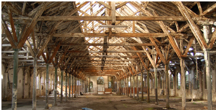
Die 1874 erbaute Alte Dreherei mit der einzigartigen Holzkonstruktion wird zum neuen Vereinshaus der Eisenbahnfreunde Mülheim
